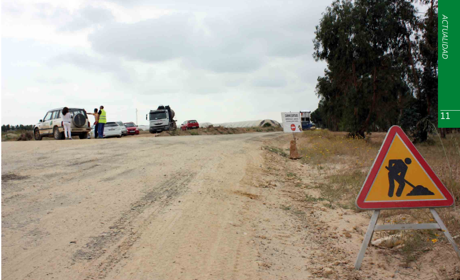
Obras en caminos rurales.
