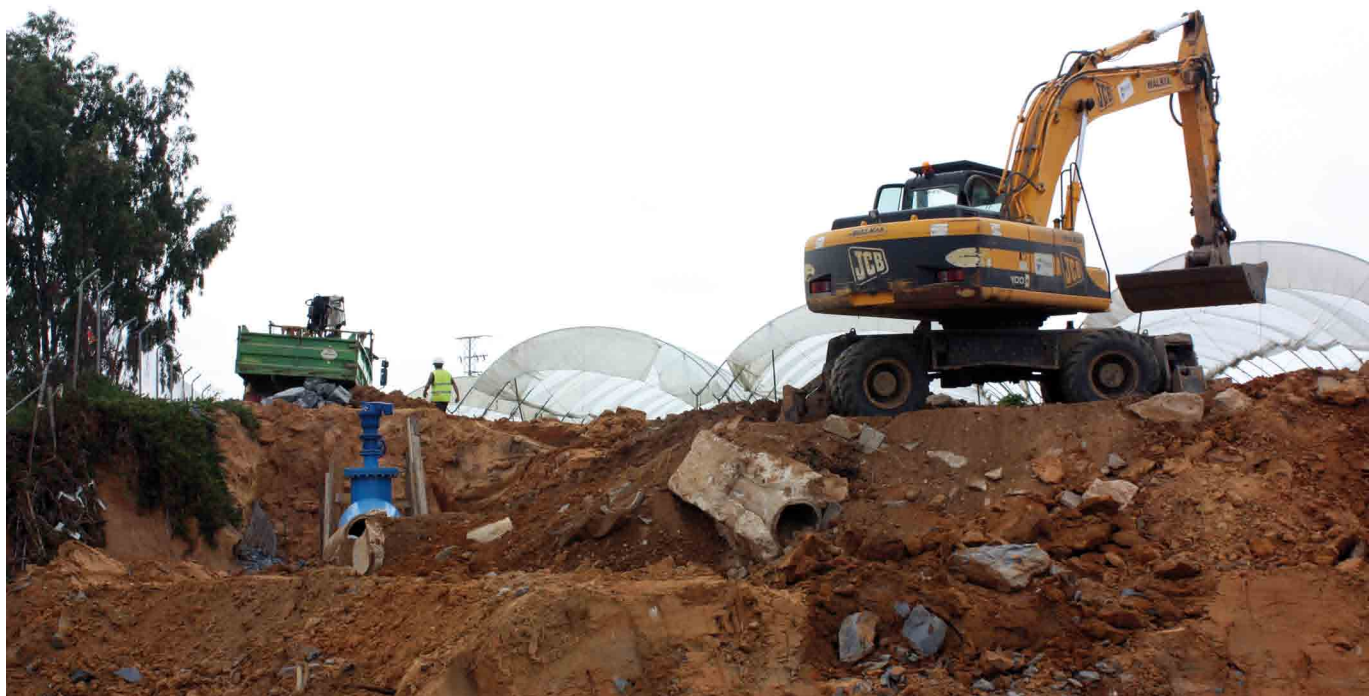
Arriba, a la izquierda, la nueva estación de bombeo de Montemayor, y a la derecha, las labores de adecuación de los alrededores de las balsas y la sala de control. Sobre estas líneas, la colocación de unas piezas en la traza de una tubería de las obras de Impulsión.
