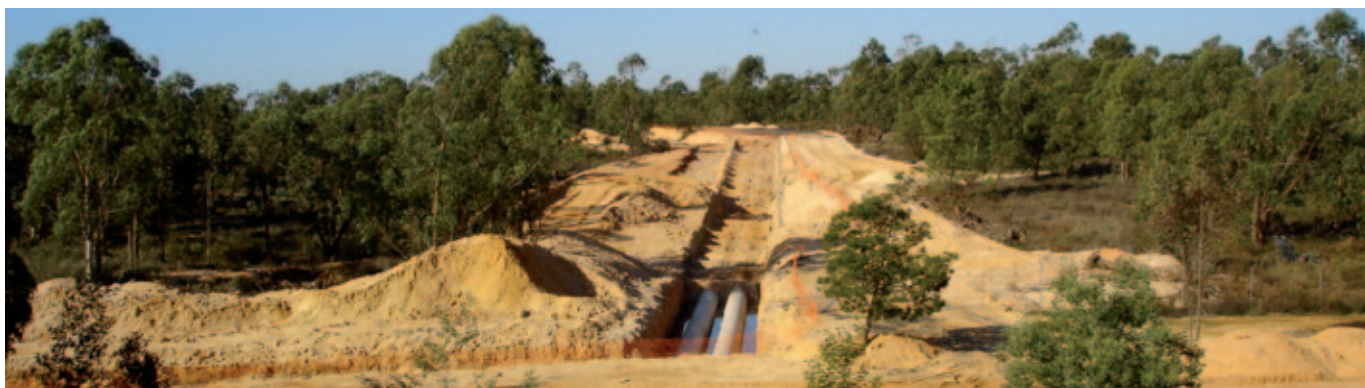
Estación de Hidroguadiana en 2008 y 2009
