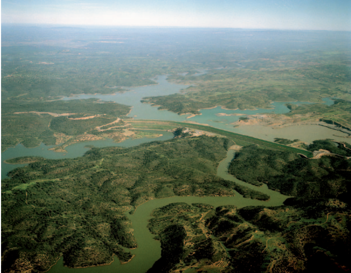
Vista aérea de la presa del Andévalo.
