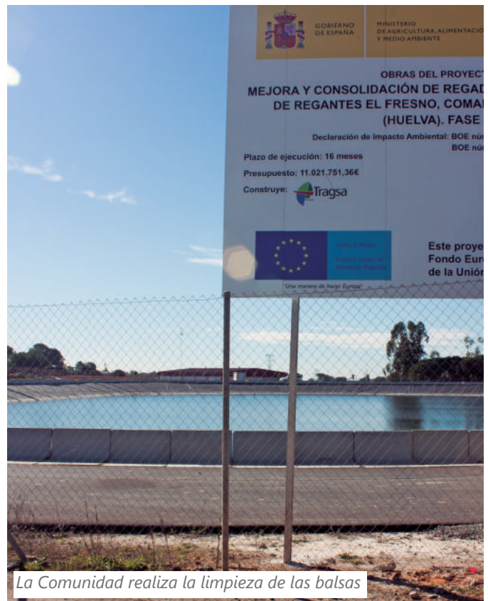
Obras de mejora del servicio
