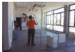
16-20 Repasamos las obras de modernización de la comunidad de regantes
